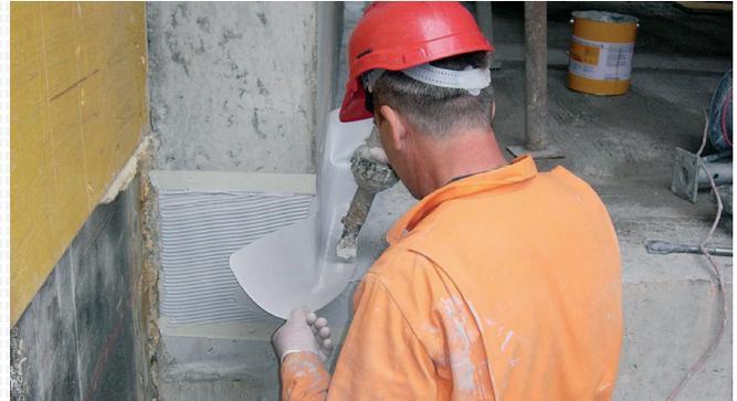
Auch Ecken und Kanten sind für unser geschultes Fachpersonal kein Problem. Mit Hilfe von Schweisskolben wird das Band auf die gewünschte Geometrie angepasst.
