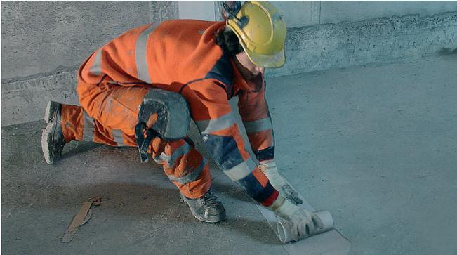
Das waprotec Abklebesystem ist für Arbeitsfugen, Dehnfugen und Risse geeignet. Mit Epoxidharz-Kleber wird das thermoplastische Elastomer-Band auf die entsprechenden undichten Stellen aufgetragen und gewährleistet somit eine 100%ige Dichtigkeit.
